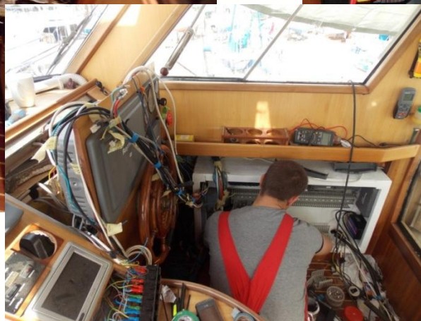
W trakcie pracy...
