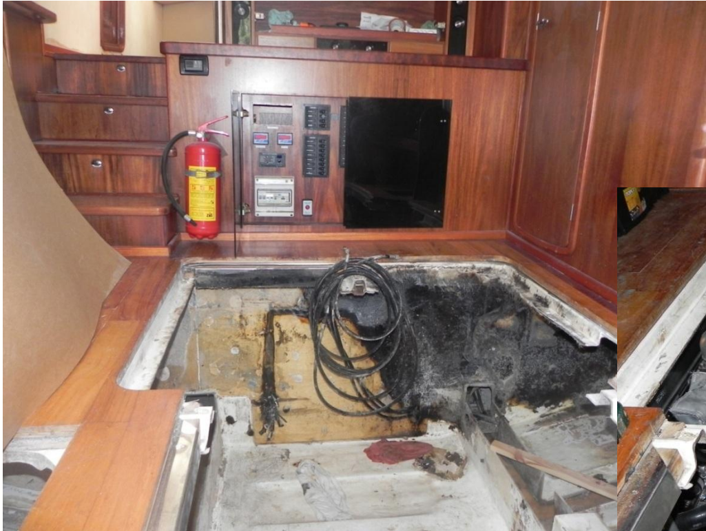
Spalona część maszynowni
